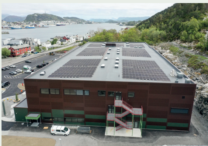
Osane idrettshall sett fra vest. Ståltrappen er levert av Midthaug.
