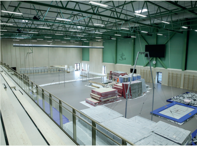
Det toetasjers bygget med blant annet resepsjon, sosiale soner og kontorer har dekket fasadeplater og aluminiumsvinduer fra Straumsheim.
