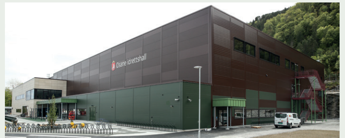
Idrettshallen sett fra nordvestlige hjørne mot hovedinngangen i venstre bildekant.
