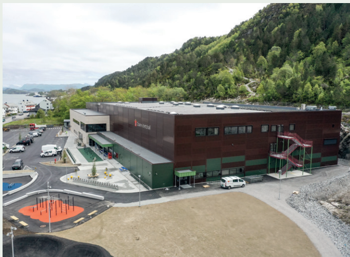
Osane idrettshall sett fra vest med deler av aktivitetsområdet i forkant. Hovedinngangen er under taket og inn på siden i det toetasjers bygget.
