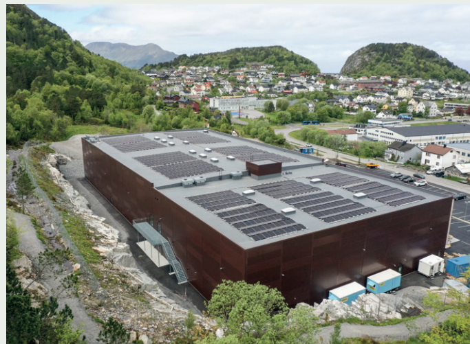
Osane idrettshall sett fra øst, med bydelen Skarbøvik i bakgrunnen. Vi ser Skarbøvik ungdomsskole noen hundre meter bortenfor den nye hallen.
